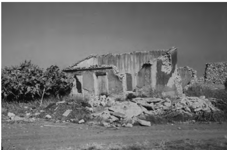
Imagen nº 8. Restos de antiguas viviendas en El Algar (Pedro Esteban García. 2002).
