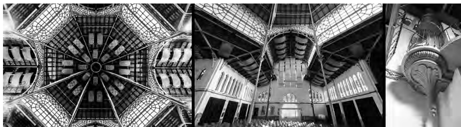
Figura 21. Vistas del interior del mercado, con la interesante estructura del edificio y la escalera de caracol en piedra artificial.
