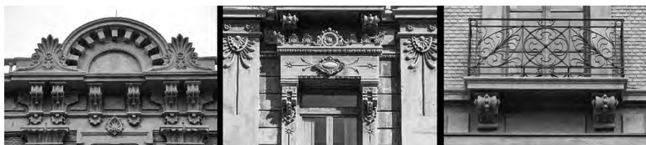
Figura 10. Vistas de detalles en piedra artificial de la fachada y rejería de balcones.
