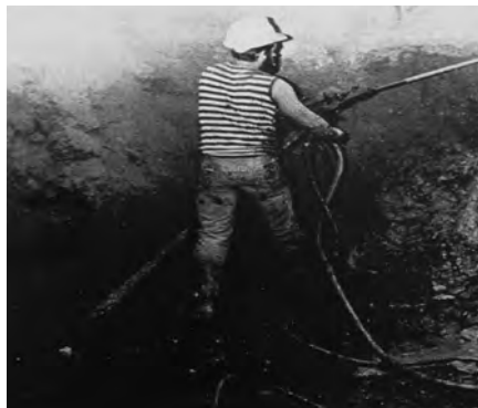
Ilustración 3. Perforista con un martillo de aire y agua. Fot. Jayam. Fuente: Mariano: La minería de La Unión. Editado por el autor, Murcia 2016.
