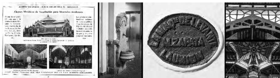
Figura 22. Página de publicidad de la casa Alberto Santamaría, suministrador de las persianas originales, fuente original de piedra artificial, sello de la fundición La Maquinista de Levante en los pilares de fundición, y dos imágenes de detalle de la estructura del edificio.
