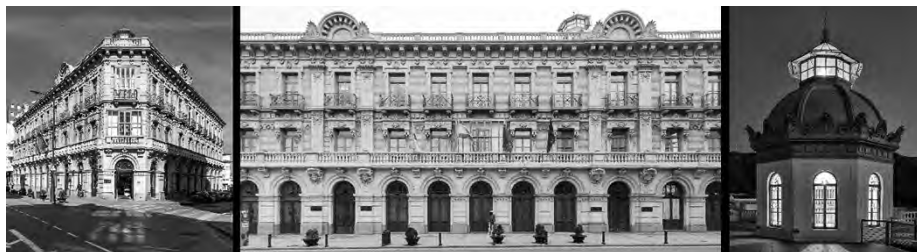
Figura 9. Vistas del exterior de la Casa del Piñón.
