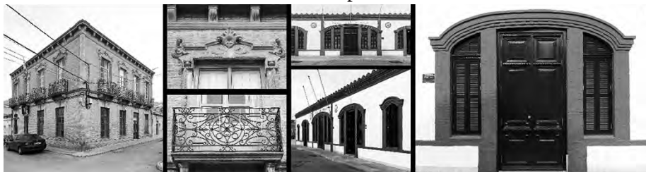
Figura 32. Vista de los edificios situados en la población del Llanor del Beal. El primero es el Casino El Progreso, con los detalles de guardapolvos en piedra artificial y la rejería de los balcones. El segundo es la Casa del Pueblo, con detalles de la fachada y huecos con recercados y parteluces en ladrillo.
