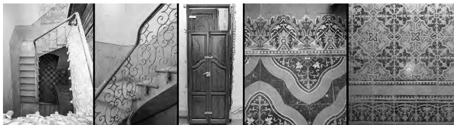
Figura 24. Imágenes del interior de la vivienda. Vistas de la escalera, de la carpintería con tallados modernistas y los singulares pavimentos hidráulicos.
