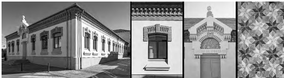
Figura 13. Imágenes del edificio de Liceo de Obreros en la actualidad. Vista general, hueco de ventana, frontón de acceso y pavimento hidráulico de la casa Carbajal Hermanos recuperado en la rehabilitación del edificio.
