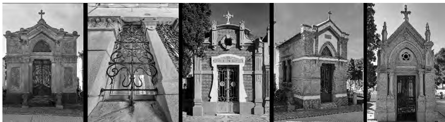
Figura 34. Vistas de los principales panteones modernistas del cementerio de La Unión. Las dos primeras imágenes corresponden al panteón de Los Salmerones, seguido del de Josefa Guijarro, con el azulejo verdoso en fachada, el de ladrillo de Gregorio Conesa y el neogótico de J. Martínez Hernández.
