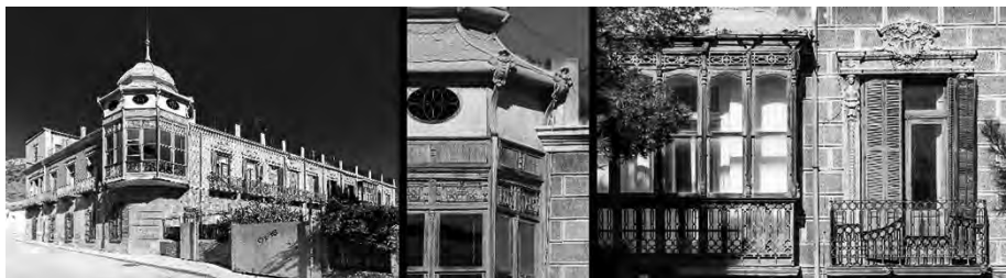
Figura 26. Vistas de la Casa del Tío Lobo. Fachada principal, detalle de la fachada lateral donde se aprecia la barandilla igual a la de la Casa Zapata de Cartagena, arranque de la escalera principal y detalle de pavimentos de mosaico Nolla de la vivienda.
