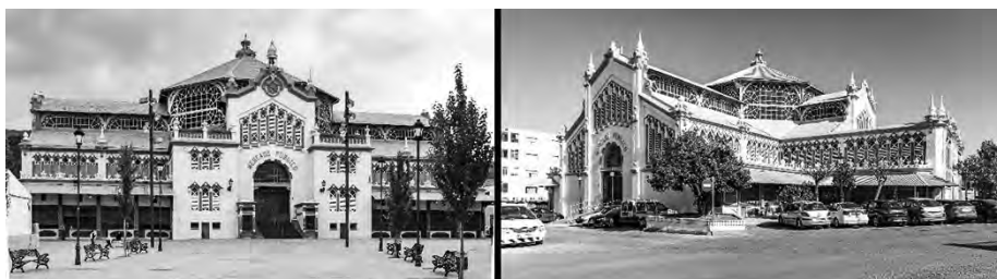
Figura 18. Mercado de La Unión. Vistas exteriores generales.
